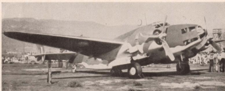
Der Rumpf des Moders Lockheed „Ventura“ ist im Unterschied von Muster Lockheed „Hudson“ hinter des Turms um rund 1 m länger, so daß sich der MG.-Turm mit Kuppel aus durchsichtigen Werkstoff (s. oberes Bild!) entsprechend weiter vom Leitwerk entfernt befindet als beim Muster Lockheed „Hudson“. Ferner weist das Muster Lockheed „Ventura“ im Unterschied zum Muster Lockheed „Hudson“ eine Stufe für das Boden-MG. an der Rumpfunterseite auf.
